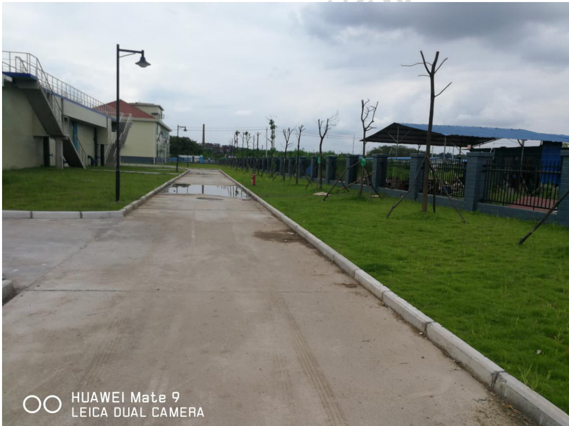
照片2 项目道路硬化区现状
